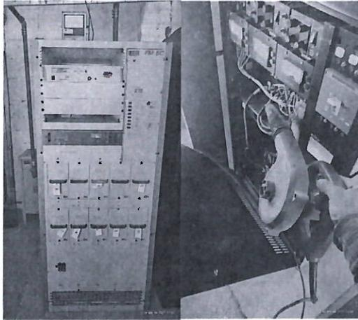
Mantenimiento al transmisor de FM y regulador de voltaje en caseta de transmisión
